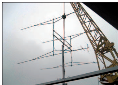
Der Kran macht es möglich... die Vierergruppe auf dem Weg zum Dach.
